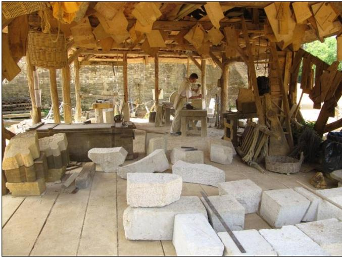
sulla base tutti i disegni occorrenti in scala 1:1 si fabbricavano le sagome in legno, a seconda delle dimensioni volute. A questo punto le si potevano portare con sé dappertutto dove servivano, in nuovi cantieri.
